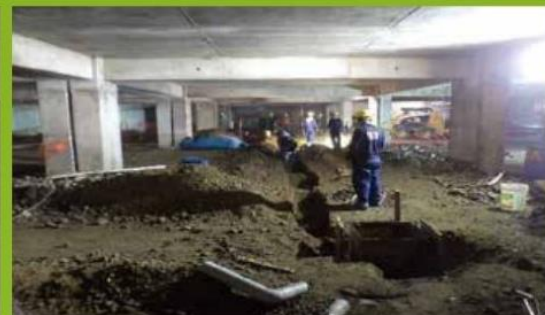
Instalación de redes enterradas Centro Comercial Miraflores
