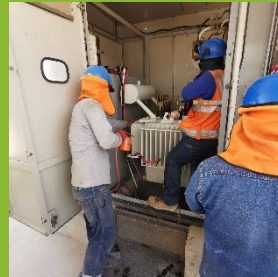
Mantenimiento de Celda de Transformación
