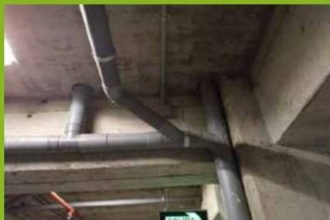
Instalaciones red de desagüe Centro Comercial Miraflores
