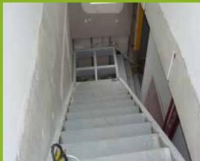
Inst. de Estructuras Metálicas Centro de Pagos Ventanilla
