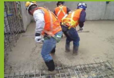
Vaciado de concreto el Loza Centro Comercial Miraflores
