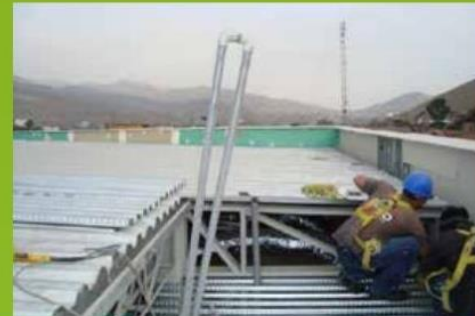
Inst. de Estructuras Metálicas Centro de Pagos Ventanilla
