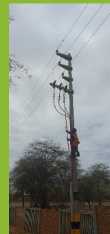
Mantenimiento de Media Tensión
