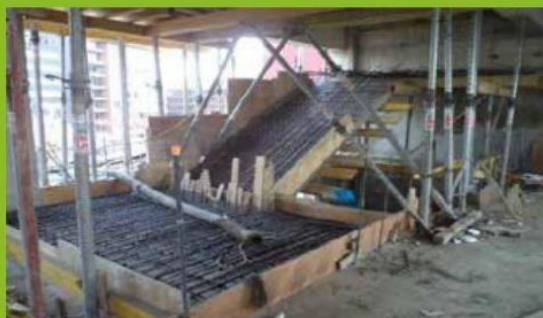
Enterrado de Escaleras Centro Comercial Miraflores
