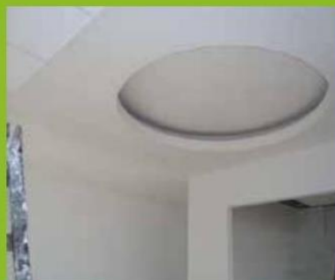
Molduras de Drywall Centro de Pagos Ventanilla
